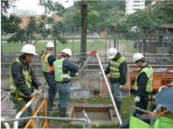
Fig. 1 Open a manhole 圖一. 開沙井
