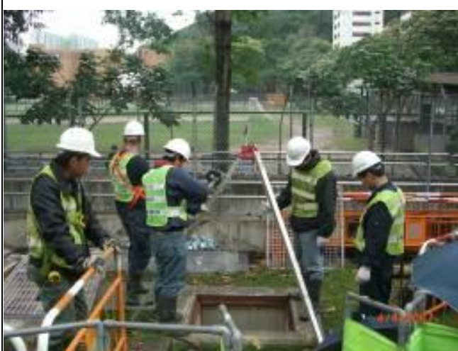
Fig. 1 Open a manhole 圖一. 開沙井
