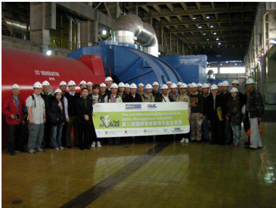
參觀團參觀八號渦輪及鍋爐機房
