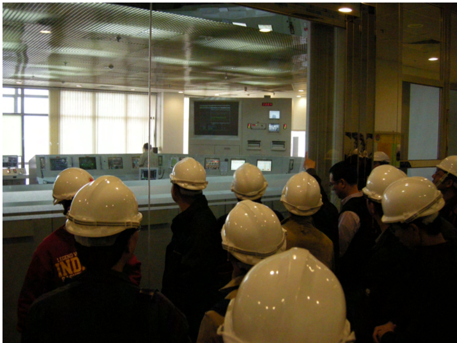
參觀團參觀發電廠二號控制室
