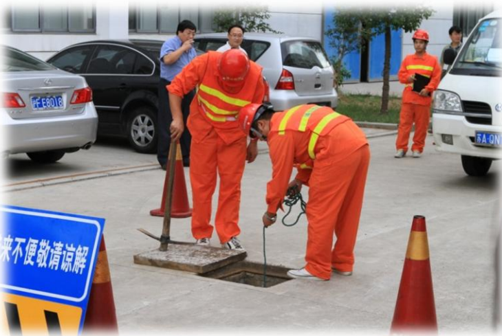
上海浦公建設工程質量檢測有限公司作 CCTV 檢測流程示範
